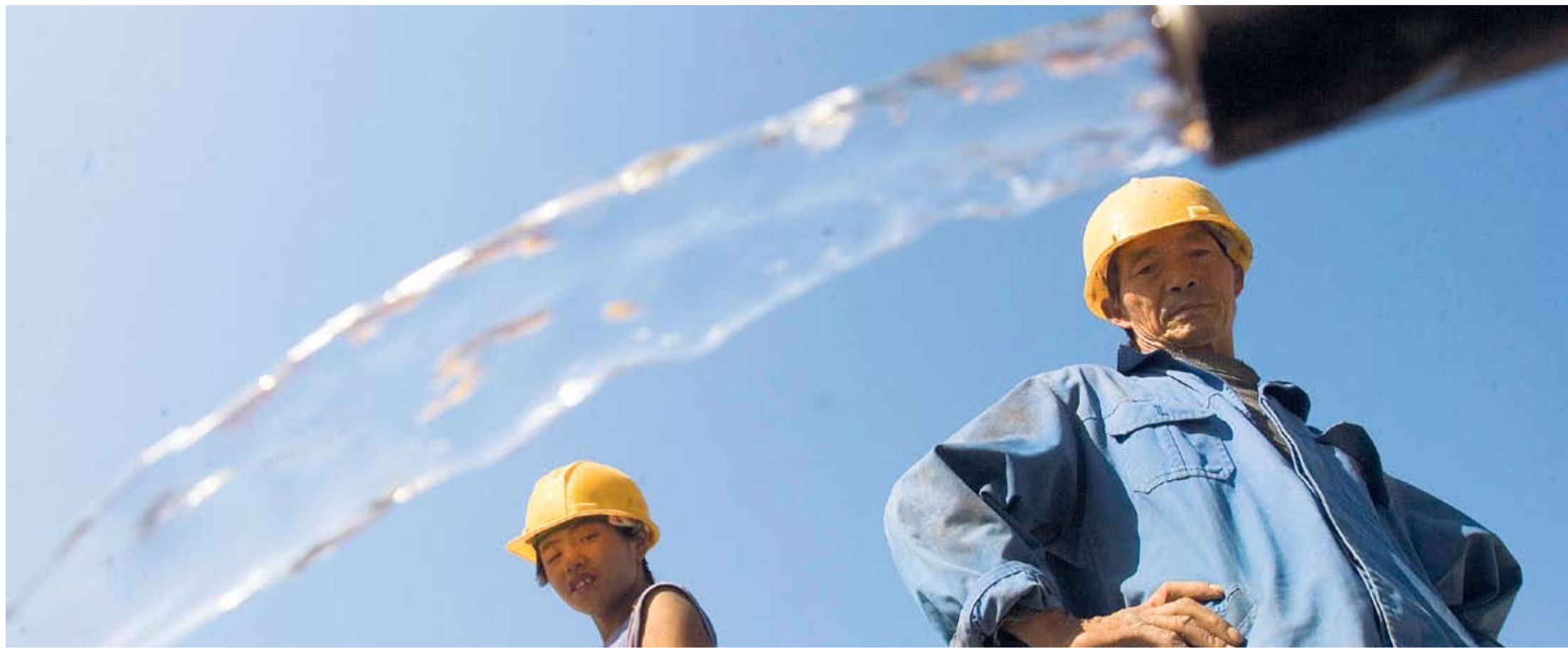
In Peking wird das Wasser wegen Knappheit rationiert. Die Arbeiter auf einer Baustelle in Chinas Hauptstadt können von Glück reden, wenn kühles Nass aus der Rohrleitung fliesst.
